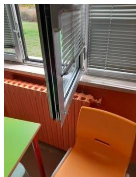
I serramenti esterni delle finestre delle aule sono costituiti da profilati metallici con bordi contundenti, in grado di provocare ferite da taglio in caso di urto.
