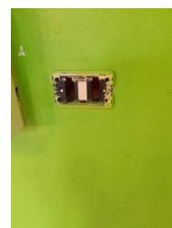
**Nella classe IIIA è presente punto luce pericoloso, con componenti schiacciati e da sostituire (vi è anche un punto lan da fissare correttamente); in VA il punto luce ha i fili a vista e deve essere sistemato. Anche nel corridoio deve essere sistemato correttamente il punto luce.**
