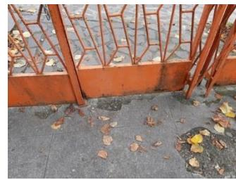
**La scalinata in cemento che porta dal cortile interno alla palestra comunale è in pessimo stato e costituisce pericolo. La ringhiera della scala è pericolosa (è staccata dai gradini in alcuni punti): urge intervento di sistemazione.**
